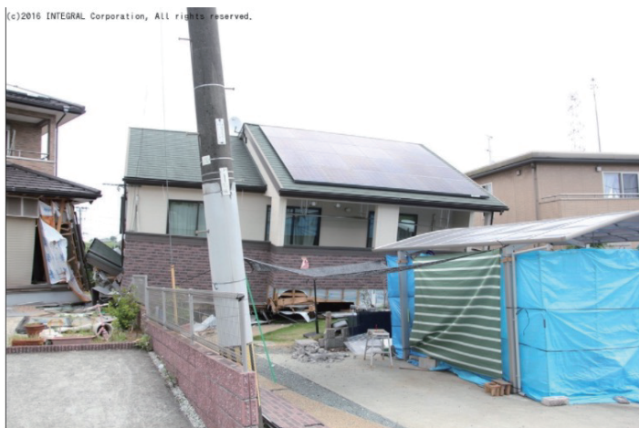
2016 年の熊本地震の被害の様子。耐震等級 2 の家が全壊した。
